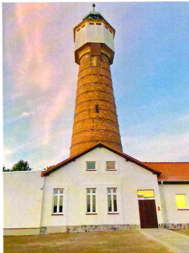
Wieża ciśnień wraz z wyremontowanymi budynkami stacji wodociągowej
